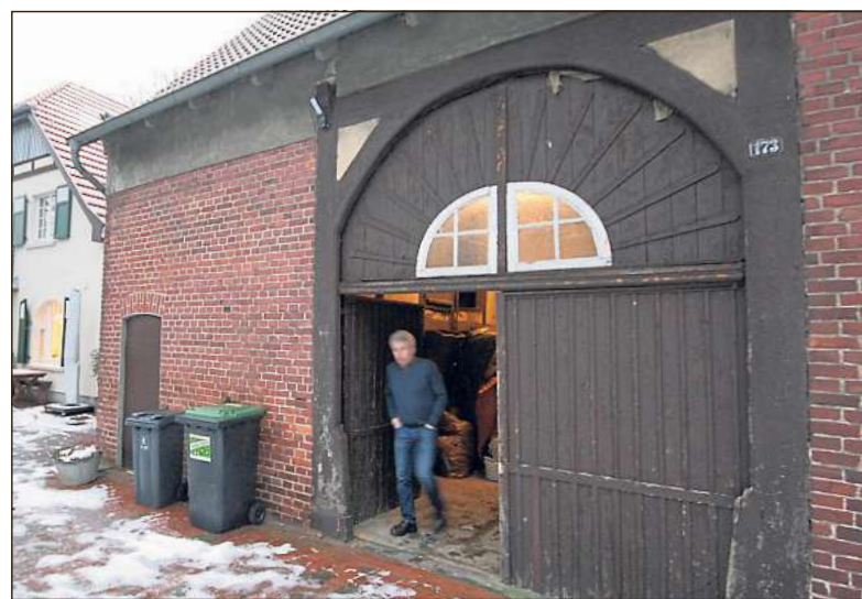
Die verklärte Scheune mit dem großen Tor von 1920 soll ebenfalls zu einem Wohnhaus umgebaut und veräußert werden. Die Planung erfolgt in enger Abstimmung mit dem Denkmalschutz.
